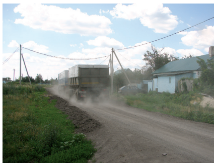
Пыль на дороге, построенной без проекта из пылевидной фракции металлургического шлака в Ленинском сельсовете Липецкого района
